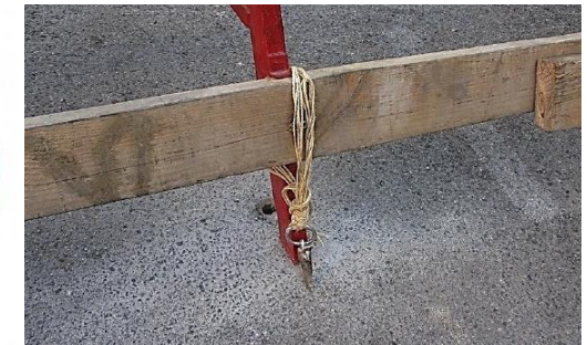
Cáncamo con resinas químicas.
