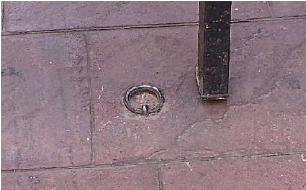
Argolla permanente junto a apoyo de tijera.
