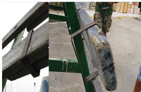
Atado con cercos metálicos.
