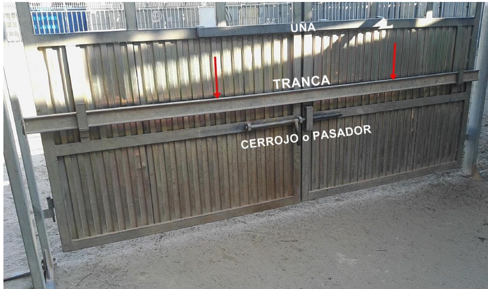
Imagen nº 1: Puerta de dos hojas en Recinto Taurino, con uña, pasador y tranca.
