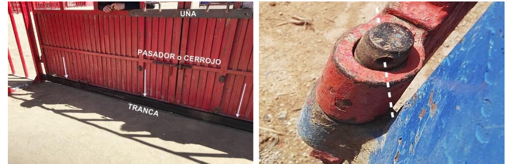
Imagen nº 2: Tranca inferior, unida a pilares de pórtico.
