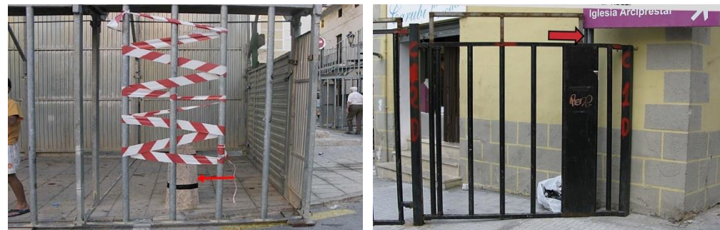
Solución provisional al obstáculo: precintado con cinta. Solución definitiva al obstáculo: chapa de acero.
