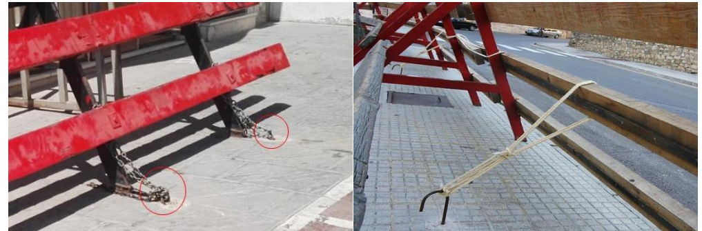
Argollas delante del apoyo delantero de las tijeras. “Argollas” detrás del apoyo delantero de las tijeras.
