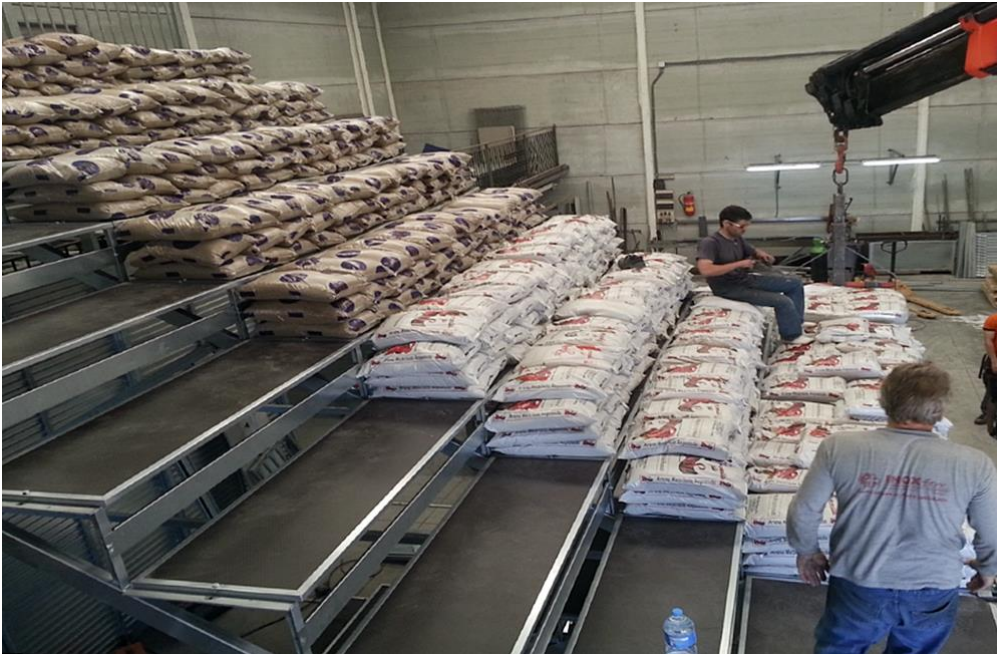
Prueba de carga de graderío.
