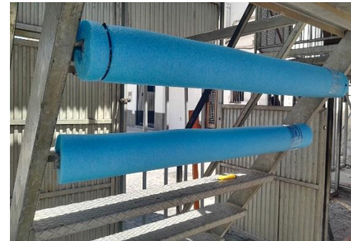
Protecciones en los escalones más expuestos.
