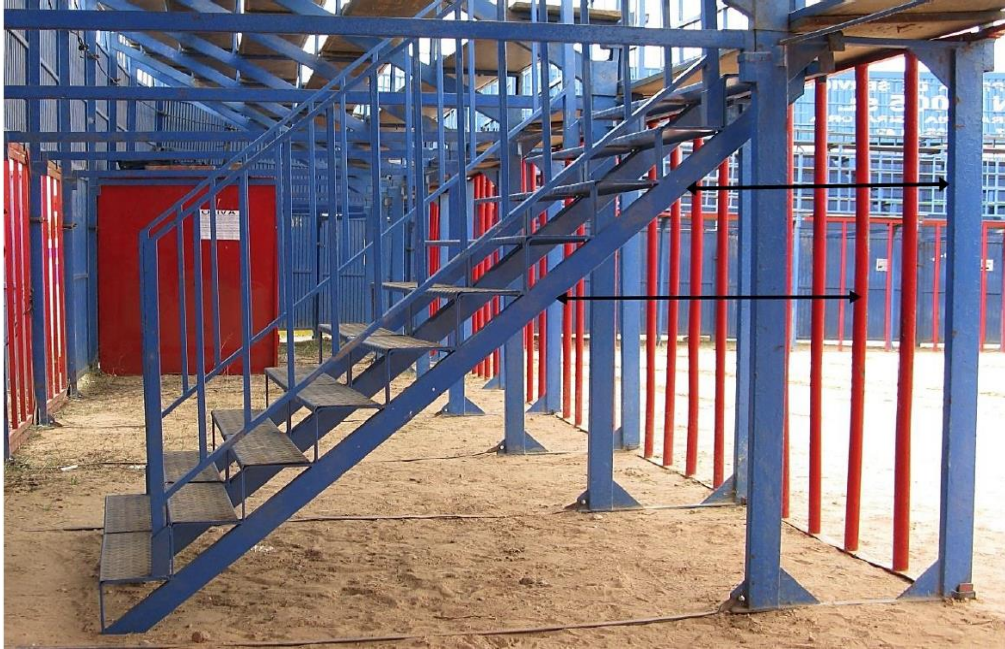
Escalera junto a barrera vertical: Riesgo de colisión.
