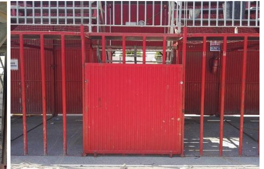
Solución definitiva: Chapa en el módulo escalera.
