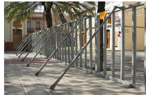
Tirantes de tubo de acero, achaflanado en extremos.
