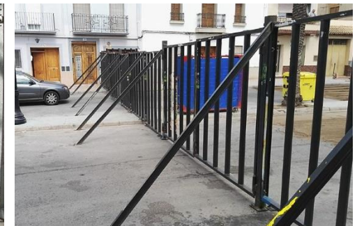
Tirantes IPN, de acero laminado en caliente.
