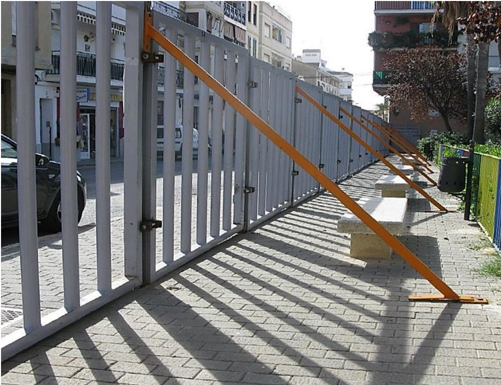
Barrera vertical de gran longitud, con tirantes.
